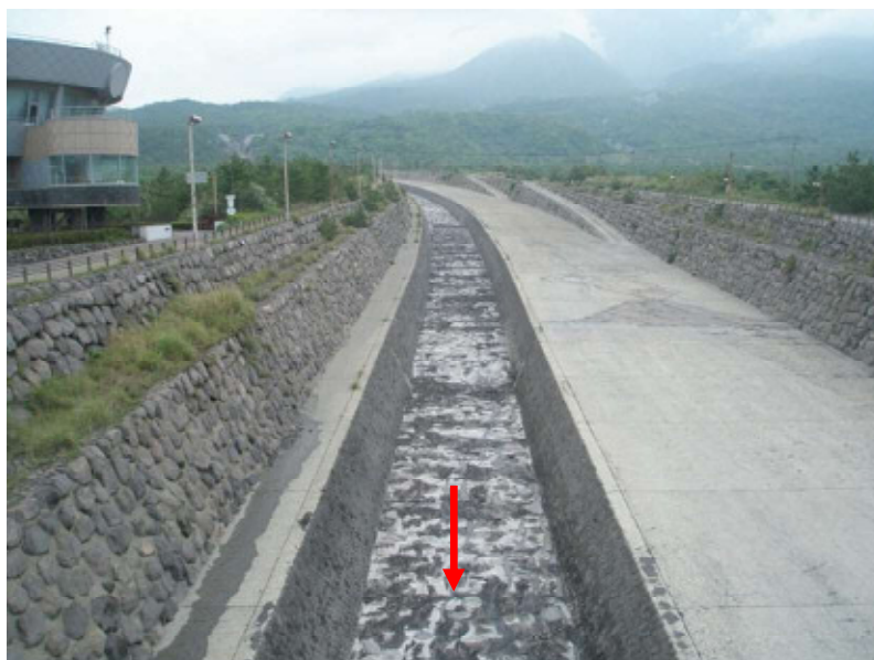
※顕著な土砂堆積は見られない。
