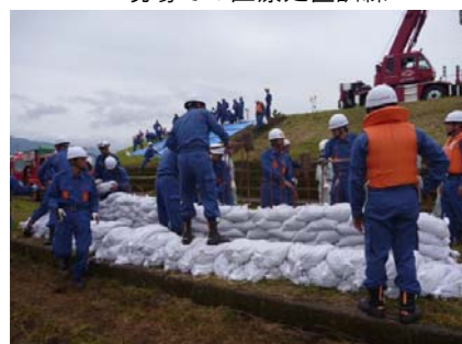
水防工法訓練（積土のう工法）
