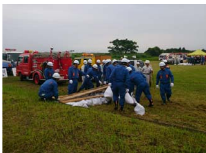
道路の小規模決壊の応急復旧訓練
