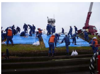
水防工法訓練（シート張り工法）
