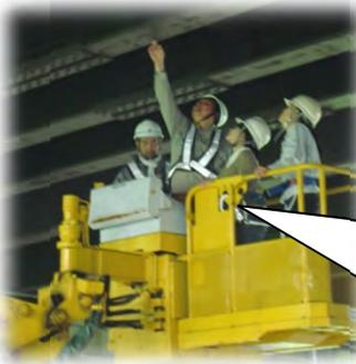
この部材、サビついています。耐候性鋼材という素材の保護性サビです。わざとサビつかせる被膜を作り、中の部材を保護しています。
