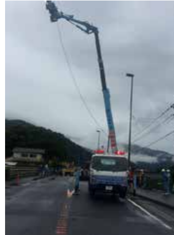
照明車の上にカメラを設置
