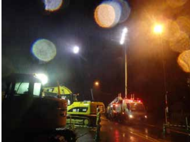
夜間作業のための照明車
