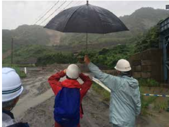
TEC-DOCTOR(鹿児島大学地頭菌教授)による 現地調査(土砂崩壊状況調査)
