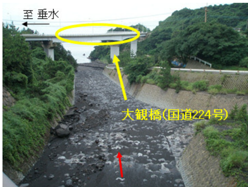
写真① 第一有村橋から下流を望む（H27.7.7 11時00分撮影）
