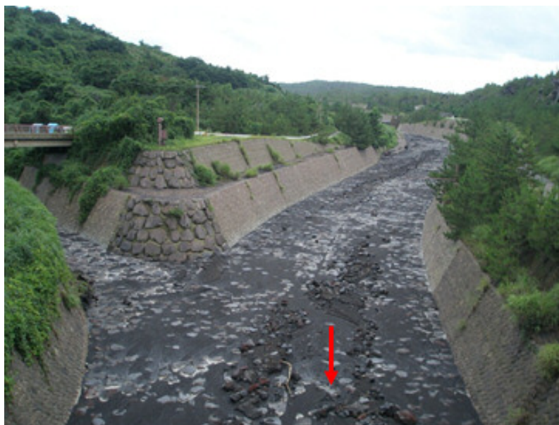
写真② 第一有村橋から上流を望む（H27.7.7 11時00分撮影）
