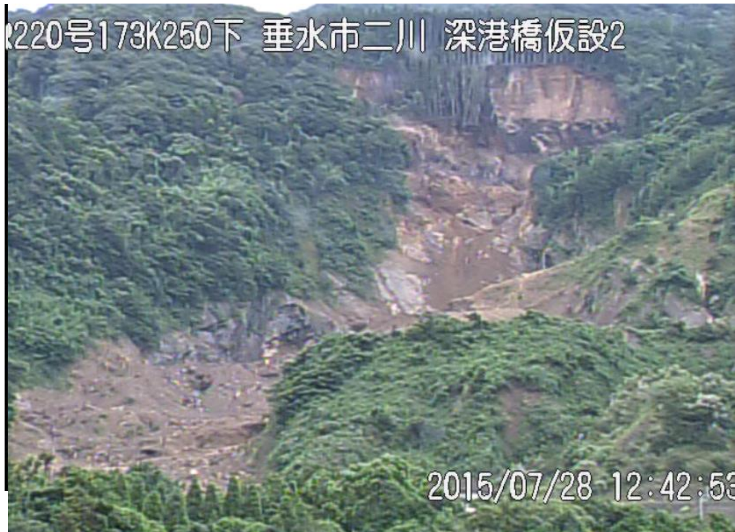
大規模な斜面崩落
