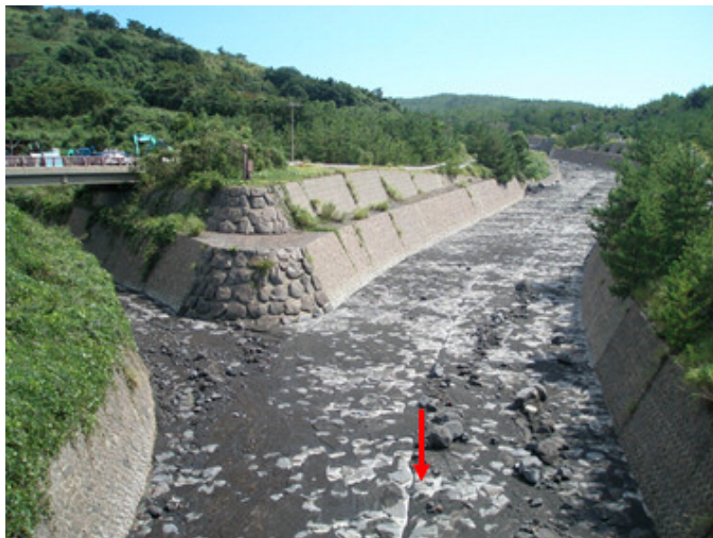
写真② 第一有村橋から上流を望む（H27.9.7 10時20分撮影）
