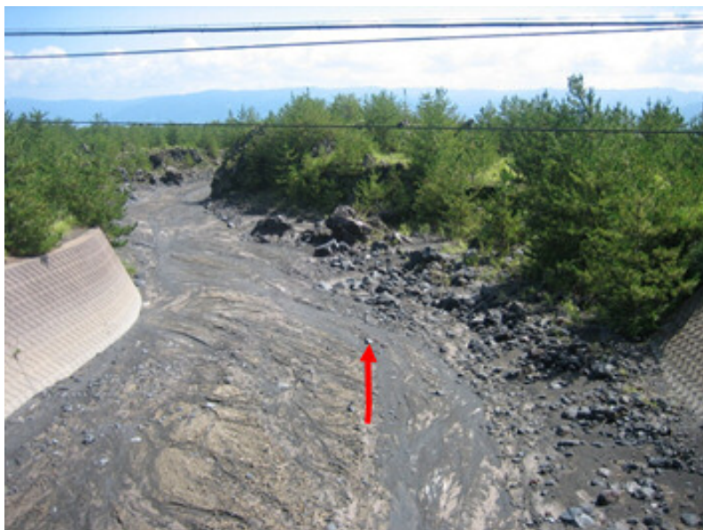
写真⑤ 第一黒神橋から下流を望む（H27.9.7 10時30分撮影）
