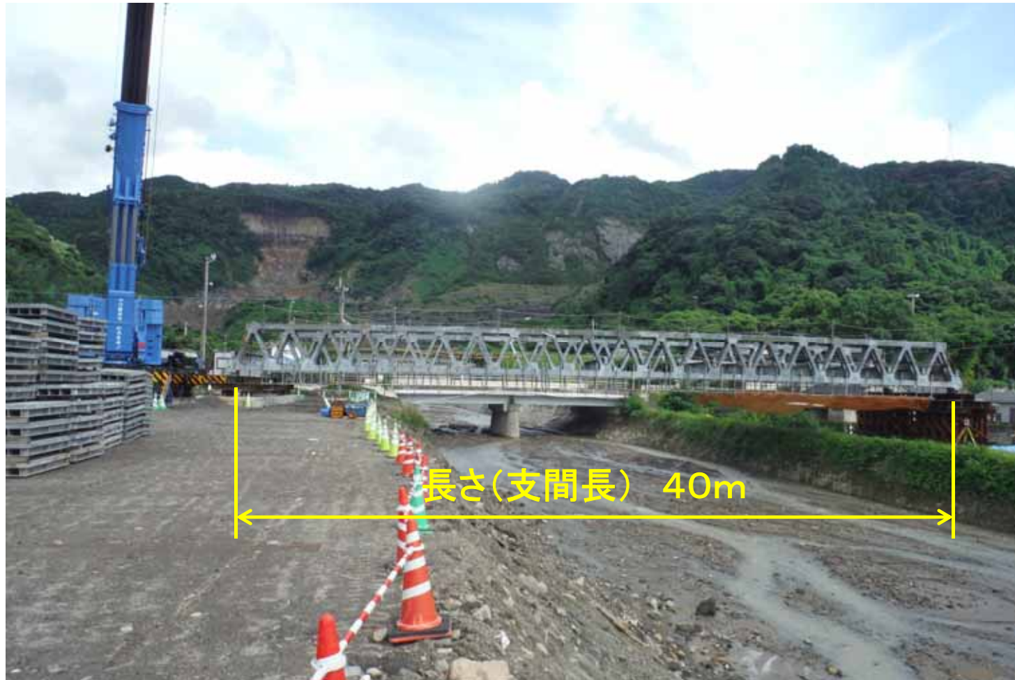
架設中の仮橋（深港川下流より）
