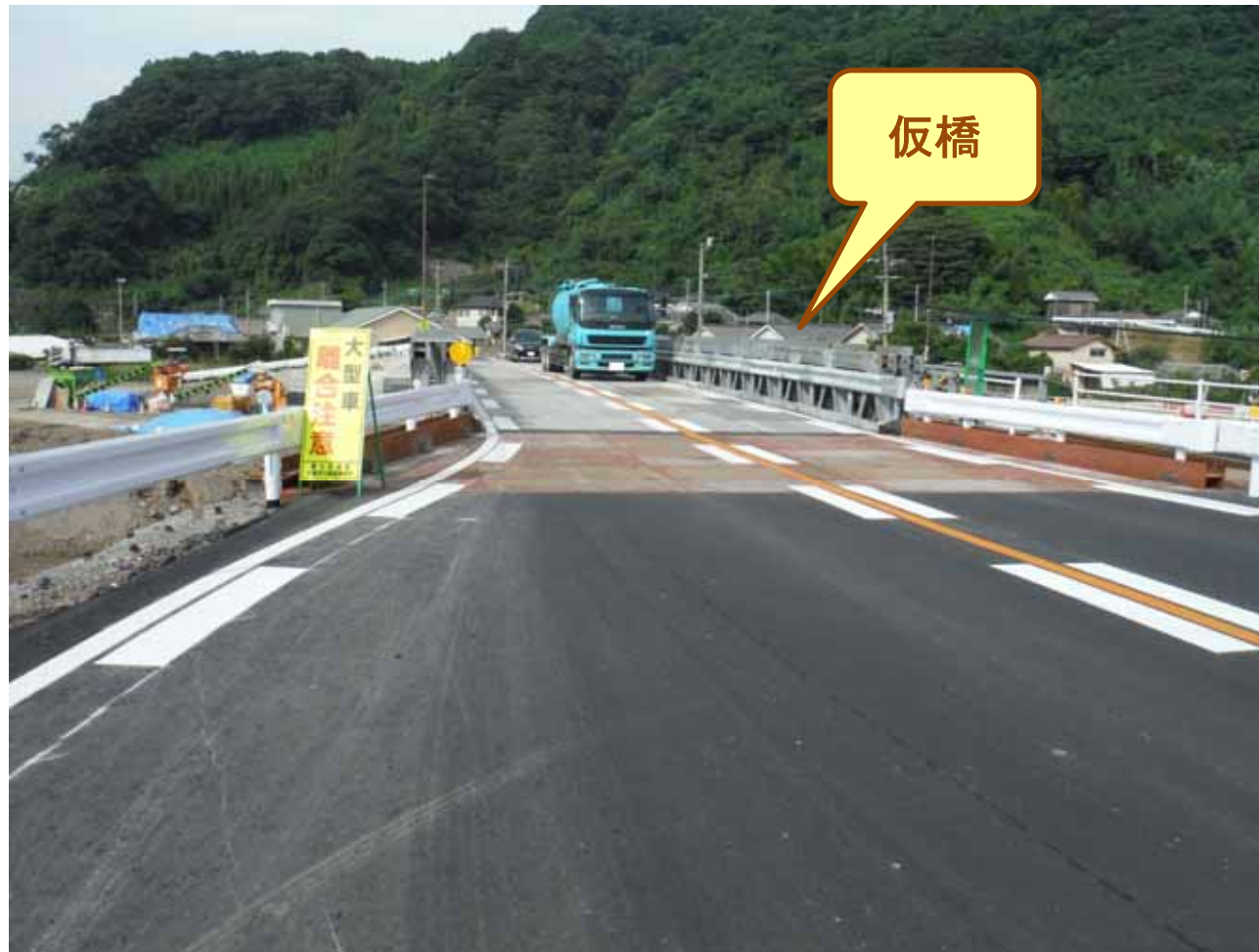
完成後の仮橋
