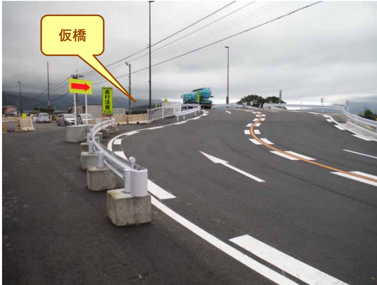
仮橋への道路
