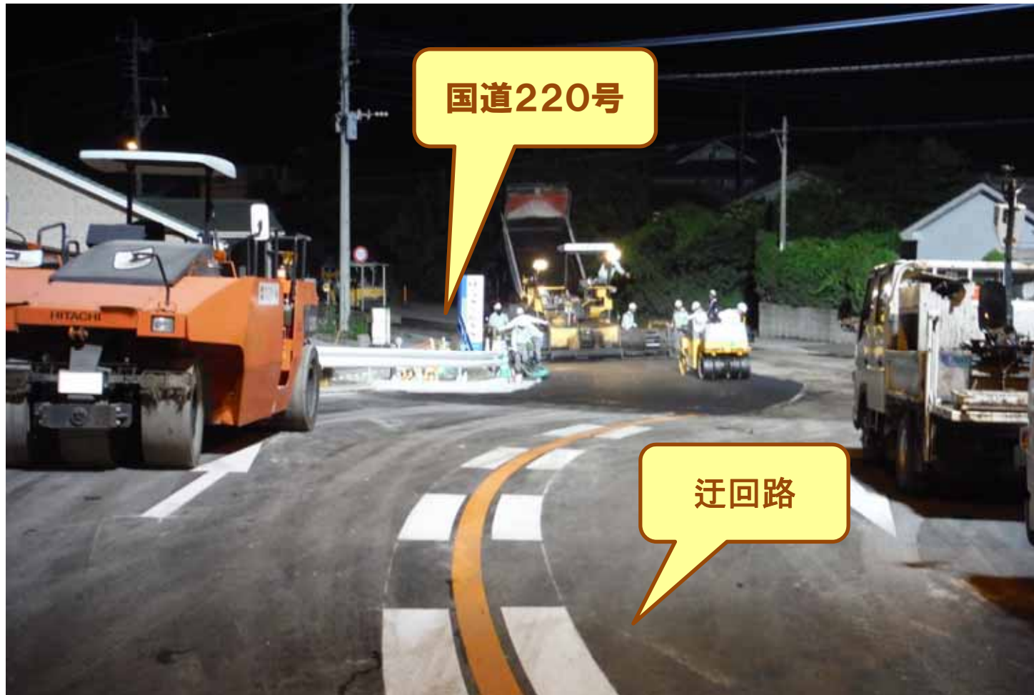
夜間工事の様子
