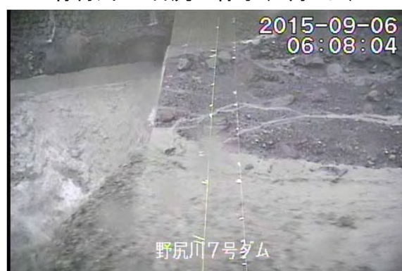
野尻川 土石流の様子(9月6日)
