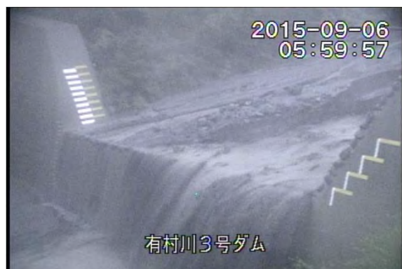
有村川 土石流の様子(9月6日)
