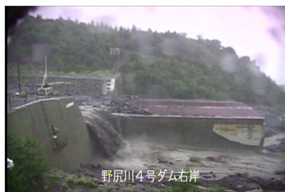
野尻川 土石流の様子(9月6日)
