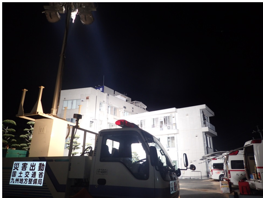
夜間作業のための照明車
