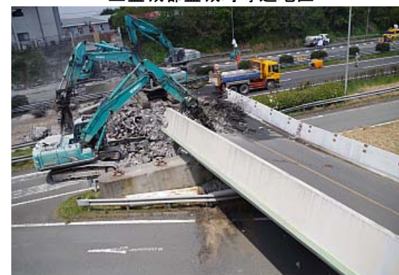
九州自動車道 緑川PA 府領第一橋落下 撤去作業
