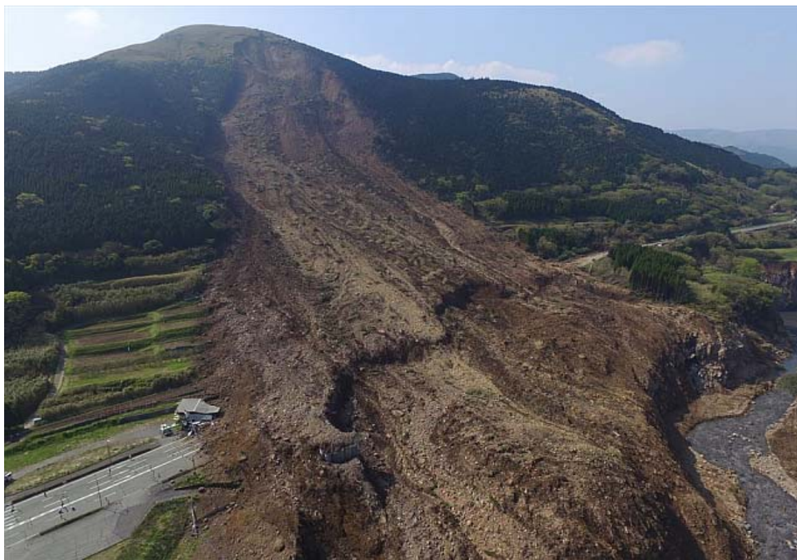
阿蘇大橋地区斜面崩壊(空撮)
