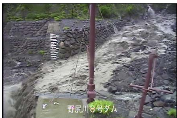
野尻川 8 号ダム
