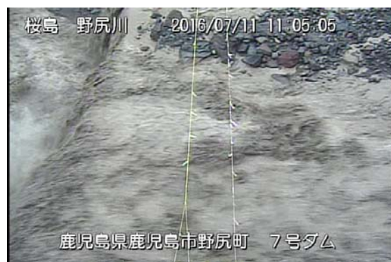
野尻川 7 号ダム
