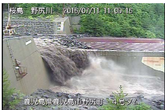
野尻川 4 号ダム
