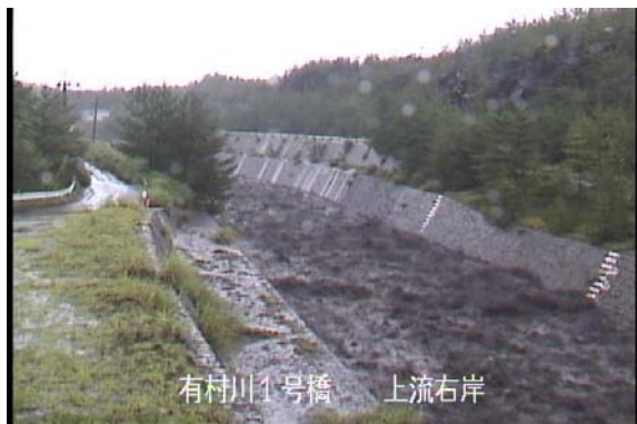
有村川 1 号橋 上流右岸
