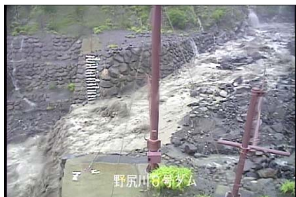
野尻川 8 号ダム
