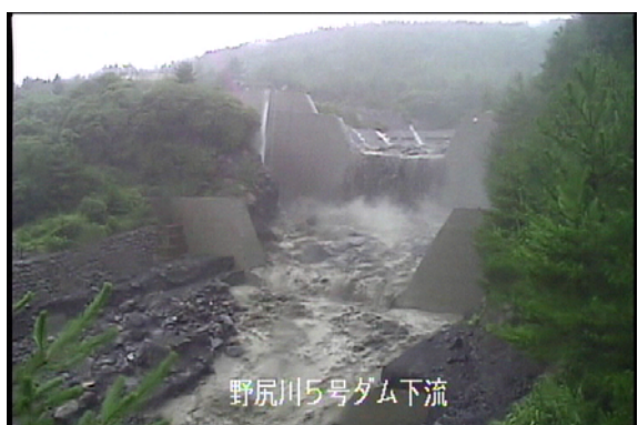
野尻川 5 号ダム
