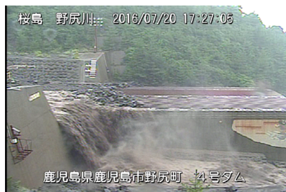
野尻川 4 号ダム
