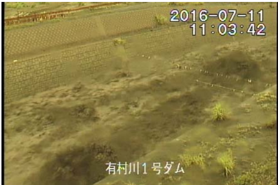
有村川 土石流の様子(7月11日)
