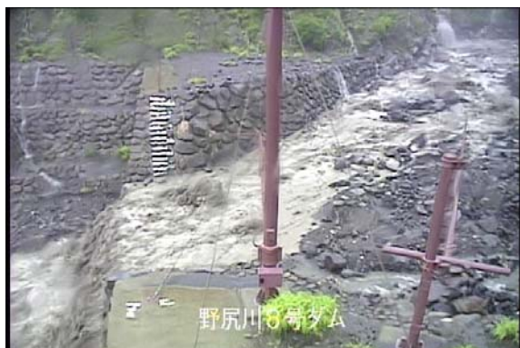
野尻川 土石流の様子(7月20日)
