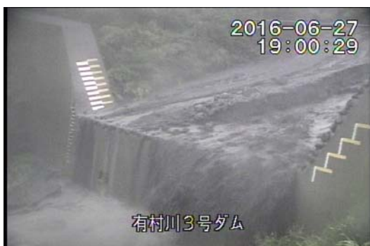
有村川3号堰堤 19:00 頃
