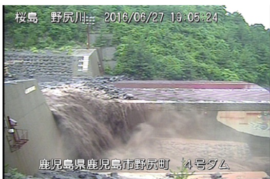
野尻川4号堰堤 19:06 頃
