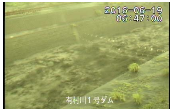
有村川1号堰堤 6:47 頃
