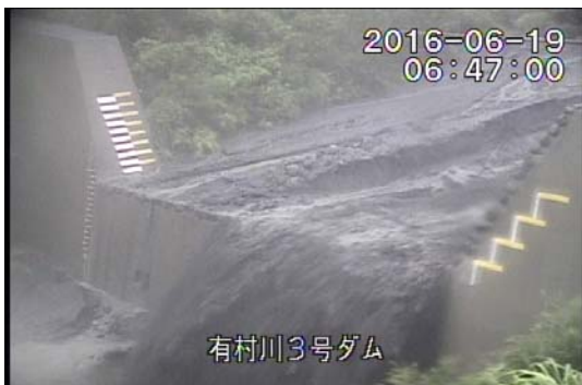
有村川3号堰堤 6:47 頃
