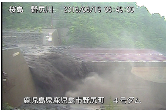
野尻川4号堰堤 6:49 頃
