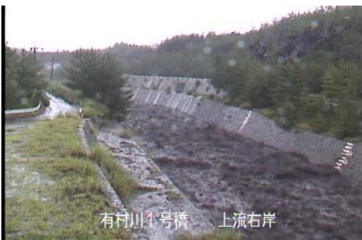
有村川1号橋上流右岸 11:03 頃
