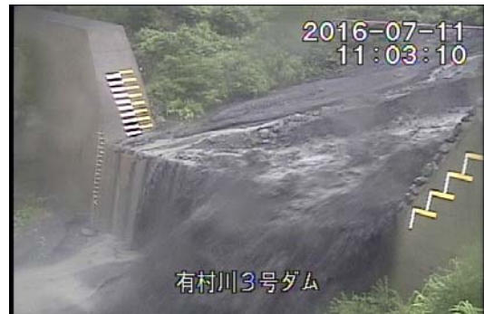
有村川3号堰堤 11:03 頃
