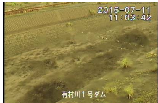
有村川1号堰堤 11:03 頃
