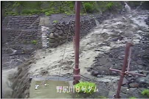
野尻川8号堰堤 11:05 頃
