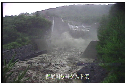
野尻川5号堰堤下流 19:05 頃
