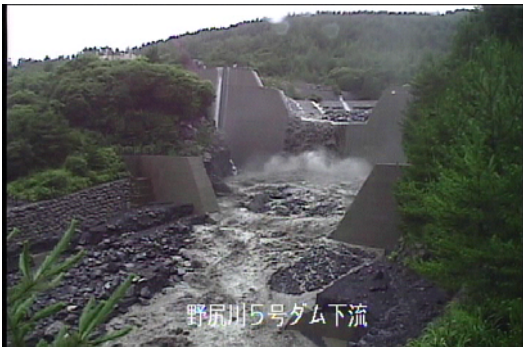
野尻川5号堰堤 11:09 頃
