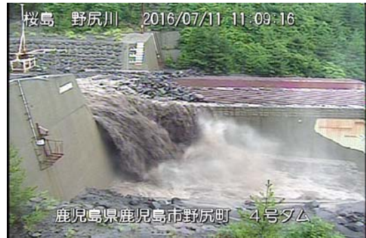
野尻川4号堰堤 11:09 頃
