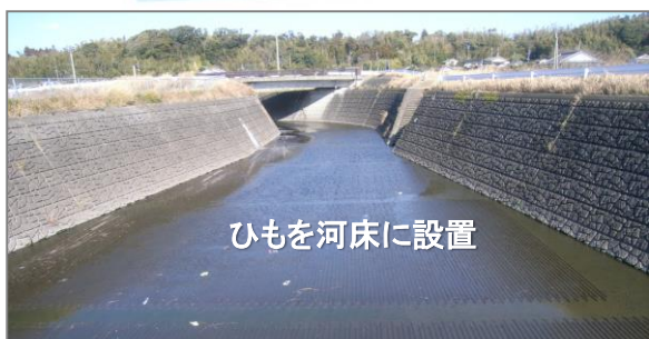
簡易な水質浄化施設(5号排水路)
