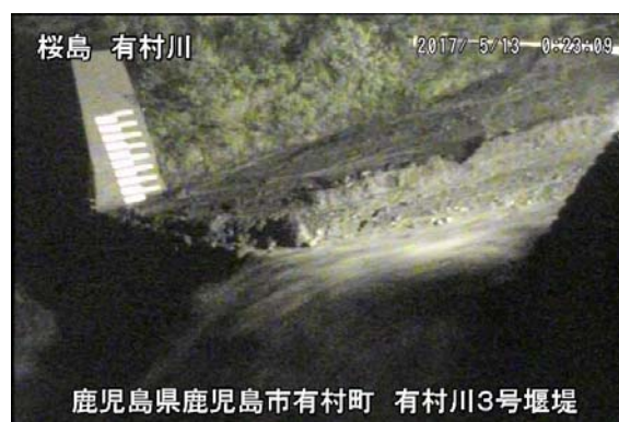
有村川 3 号堰堤
