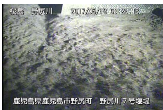
野尻川 7 号堰堤
