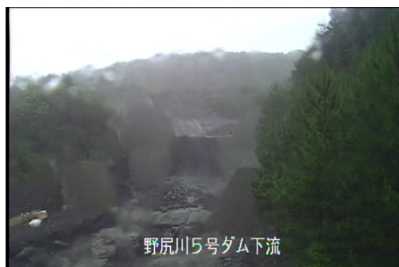
野尻川 5 号堰堤
