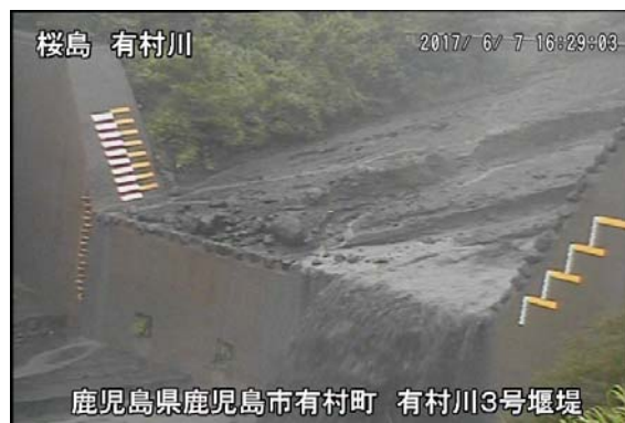
有村川 3 号堰堤
