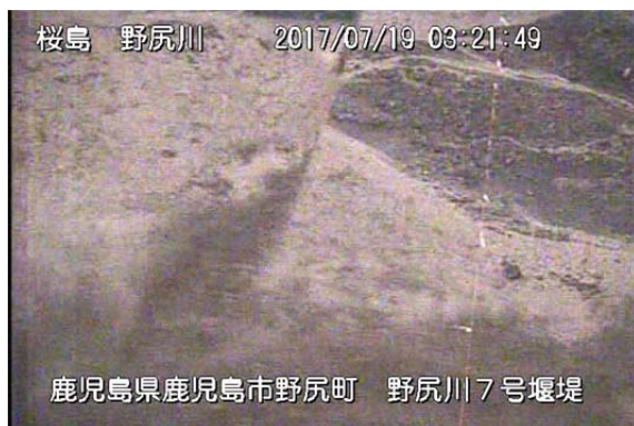
野尻川 7 号堰堤
