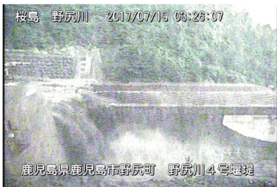
鹿児島県鹿児島市野尻町 野尻川4号堰堤 野尻川 土石流の様子(7月19日)
