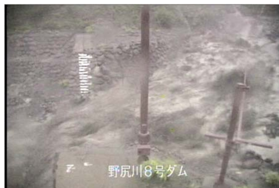
野尻川 土石流の様子(7月19日)
