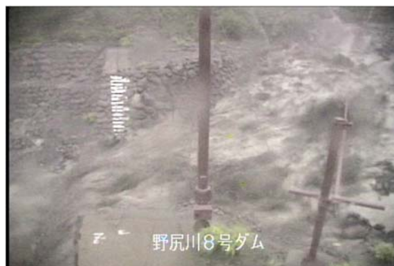
野尻川8号ダム 野尻川 土石流の様子(7月19日)
