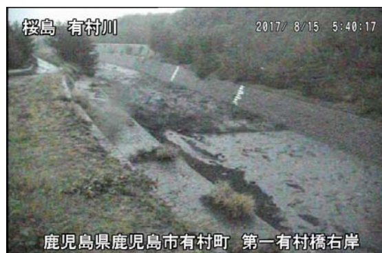
第一有村橋右岸 5:40 頃
