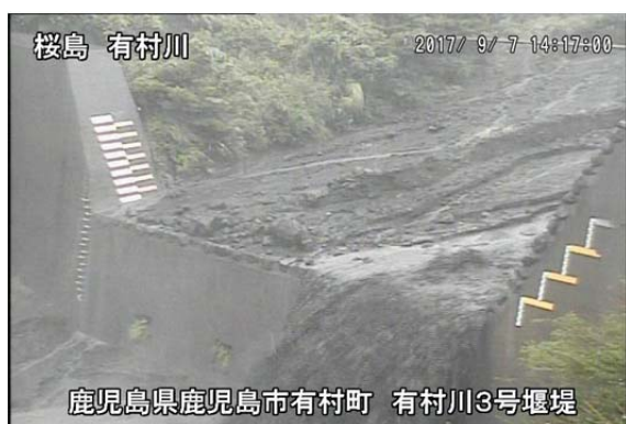
有村川 3 号堰堤
