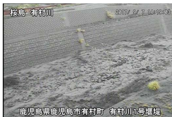
有村川 1 号堰堤
