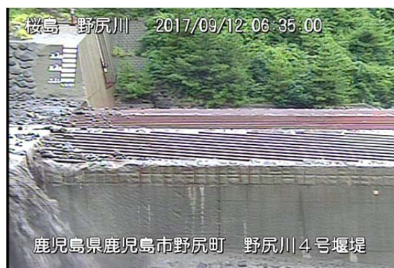
野尻川 4 号堰堤
