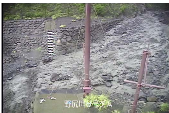
野尻川 8 号ダム
