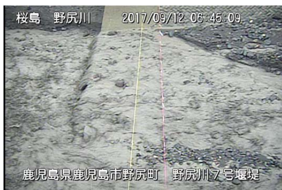
野尻川 7 号堰堤
