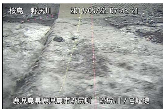
平成29年9月22日 野尻川7号堰堤
