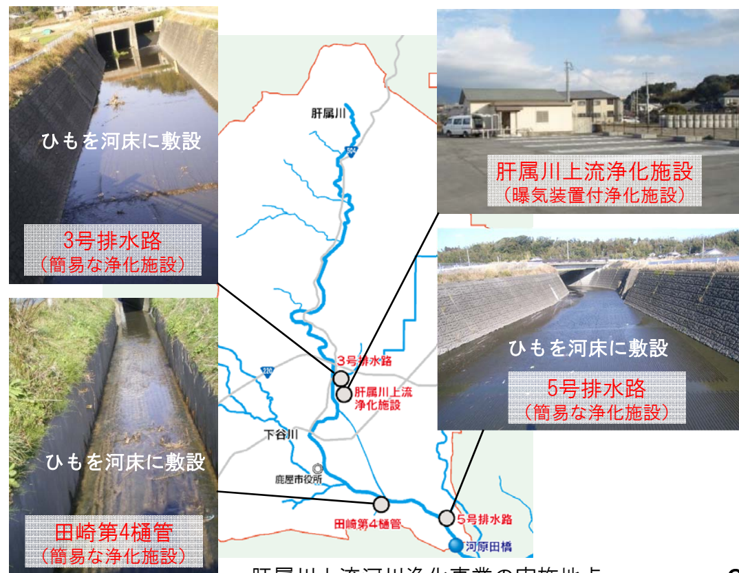
肝属川上流河川浄化事業の実施地点
