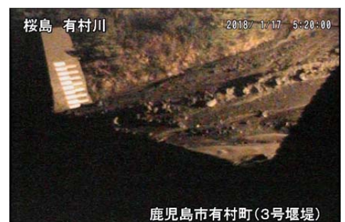
有村川3号堰堤
