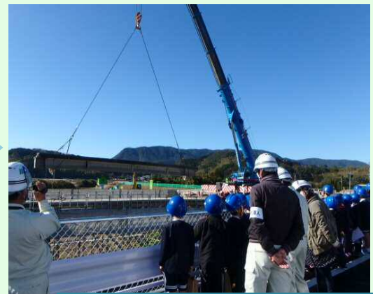
大型クレーンによる橋桁の吊り上げ
