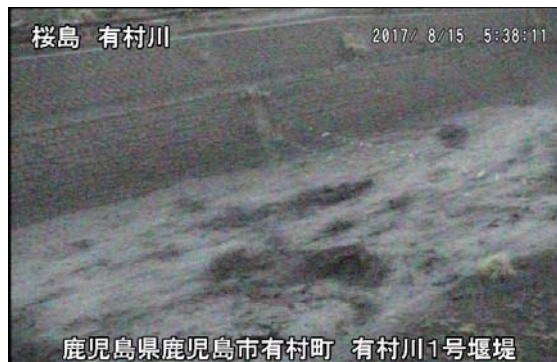
有村川1号堰堤 5:38 頃
