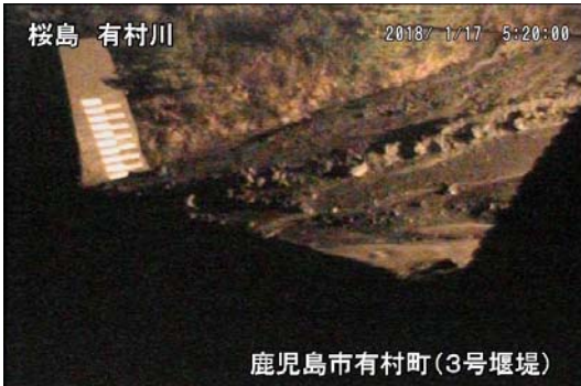
有村川3号堰堤 5:20 頃
