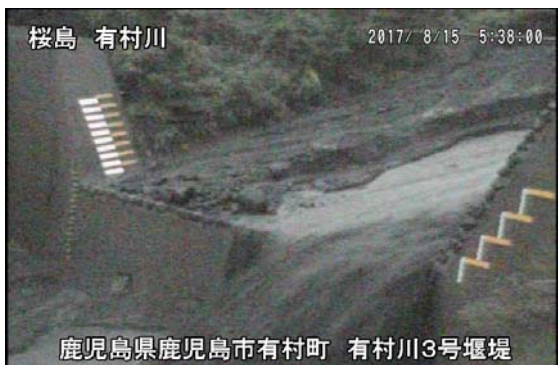
有村川3号堰堤 5:38 頃
