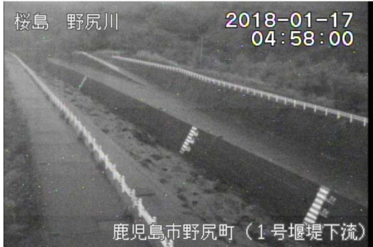
野尻川1号堰堤下流 4:58 頃
