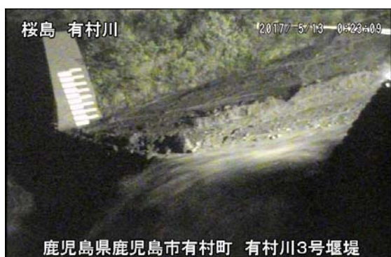
有村川3号堰堤 0:23 頃
