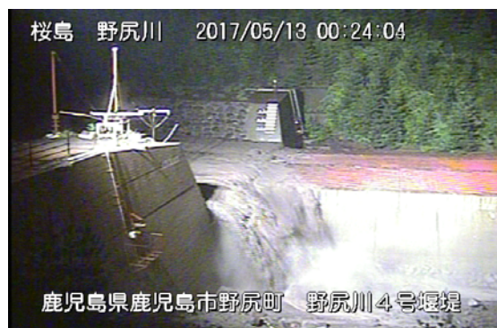
野尻川4号堰堤 0:24 頃
