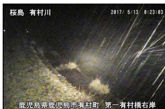
有村川1号堰堤 0:23 頃
