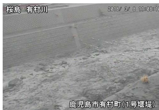
有村川 1 号堰堤
