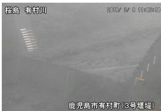
有村川 3 号堰堤
