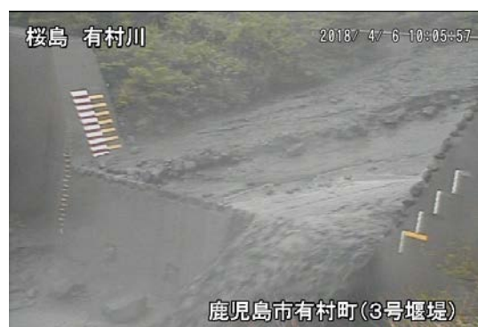
有村川 3 号堰堤
