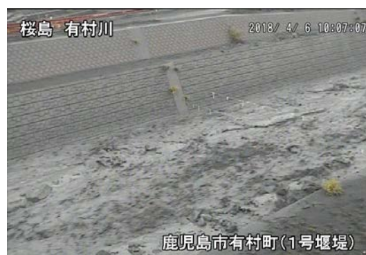
有村川 1 号堰堤
