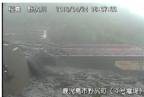
野尻川 4 号ダム右岸
