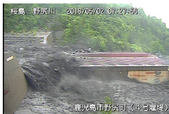
野尻川 4 号ダム右岸
