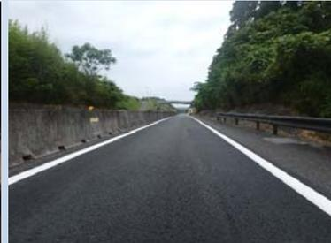
段差の生じていた路面や、傷んだ舗装の補修をしました。
