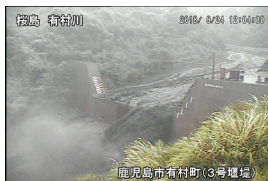
有村川 土石流の様子(8月24日)
