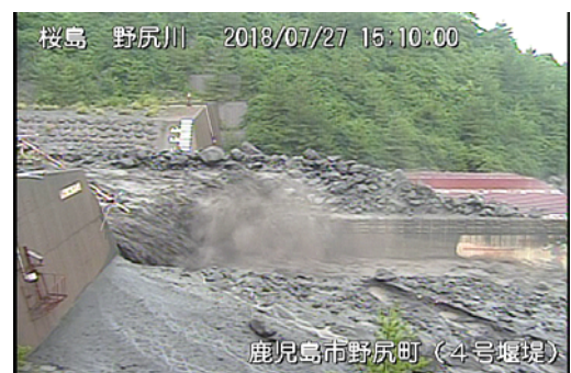
野尻川4号堰堤右岸 15:10 頃
