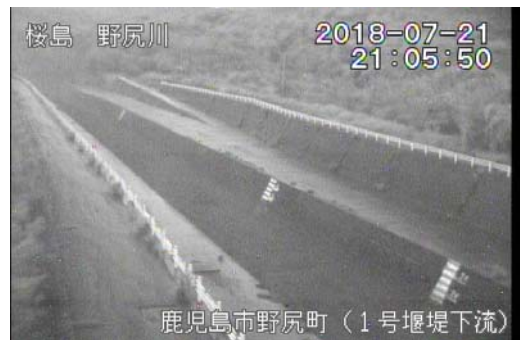
野尻川1号堰堤下流 21:05 頃
