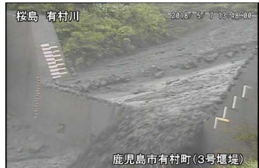
有村川3号堰堤 13:48 頃
