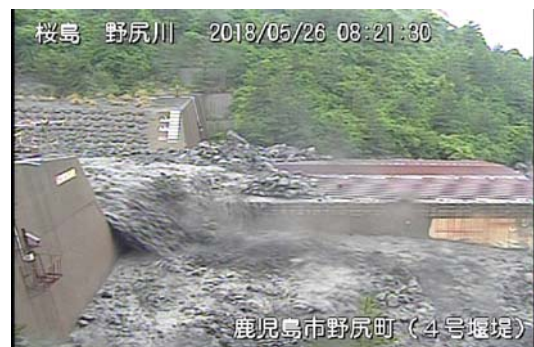
野尻川4号堰堤 8:21 頃
