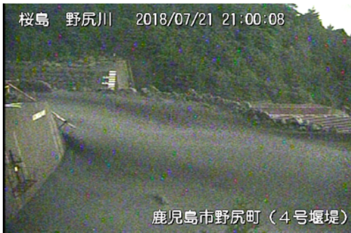
野尻川4号堰堤右岸 21:00 頃
