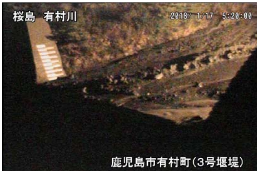
有村川3号堰堤 5:20 頃
