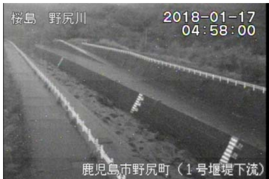
野尻川1号堰堤下流 4:58 頃
