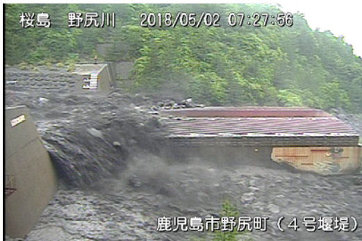
野尻川4号堰堤 7:27 頃
