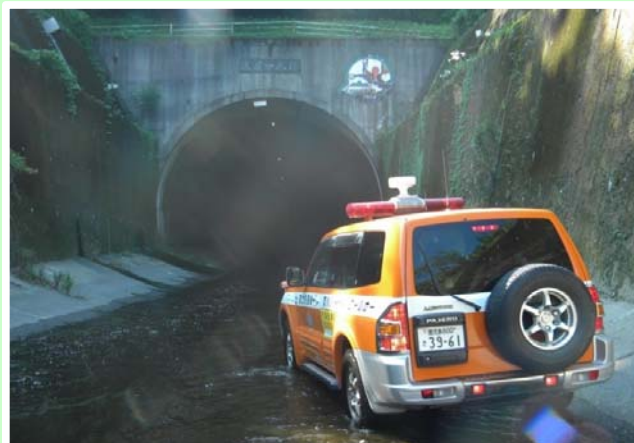
鹿屋分水路の中も毎回点検しています。
