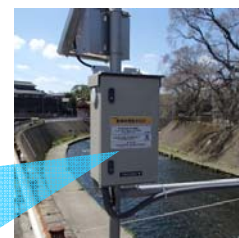
案内看板を設置しています
