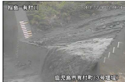
有村3号堰堤 15:14頃
