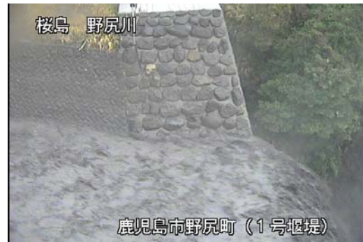
野尻川1号堰堤 15:15頃
