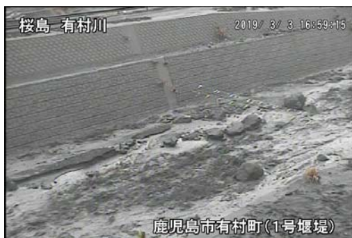
有村1号堰堤 16:59頃
