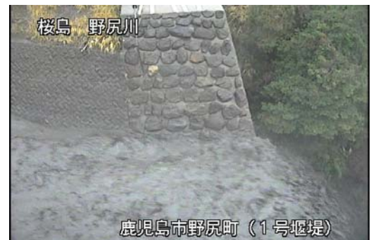
野尻川1号堰堤 16:53頃
