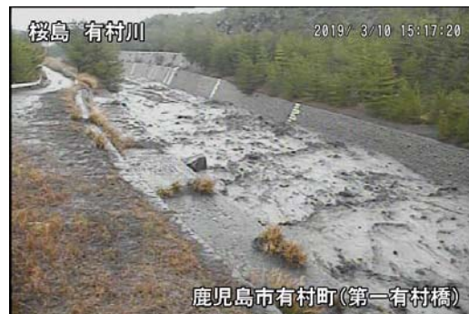
有村1号橋上流右岸 15:17頃
