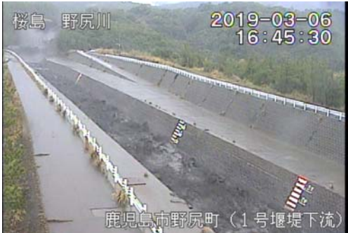
野尻川1号堰堤下流 16:45頃
