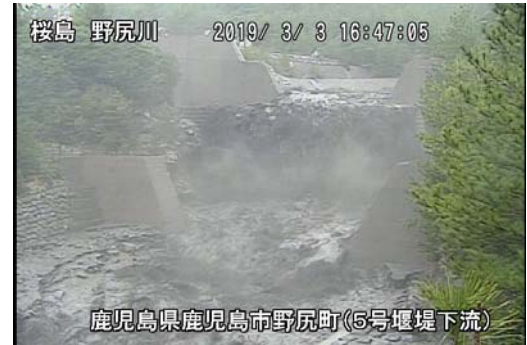
野尻川5号堰堤下流 16:47頃
