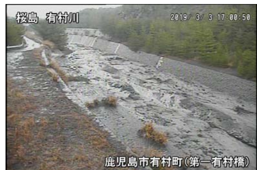
有村1号橋上流右岸 17:00頃
