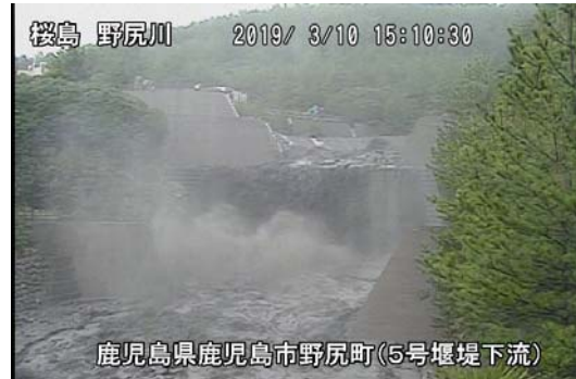
野尻川5号堰堤下流 15:10頃
