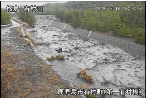
有村川 土石流の様子(3月10日)
