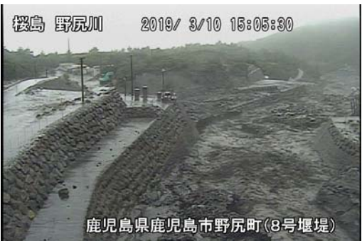
野尻川 土石流の様子(3月10日)
