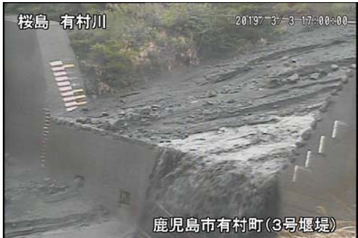
有村川 土石流の様子(3月3日)
