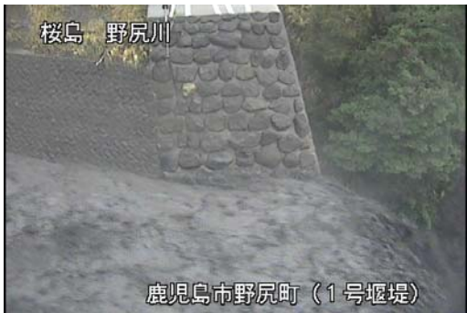
野尻川土石流の様子(3月6日)
