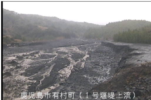
有村川 土石流の様子(3月3日)
