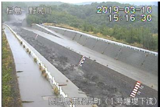
野尻川 土石流の様子(3月10日)
