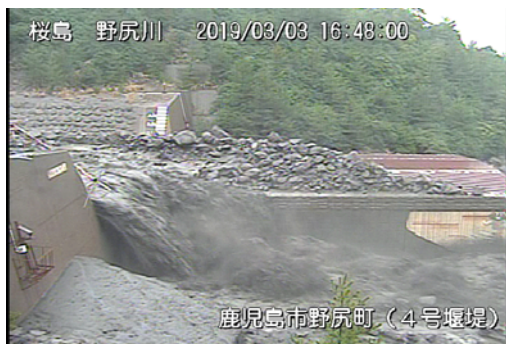
野尻川土石流の様子(3月3日)
