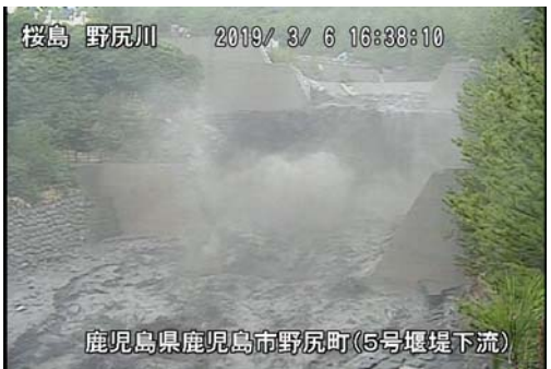
野尻川土石流の様子(3月6日)
