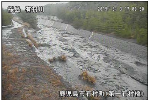
有村川 土石流の様子(3月3日)
