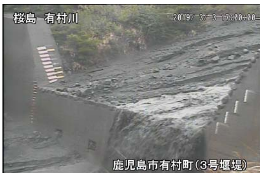
有村川3号堰堤 17:00 頃
