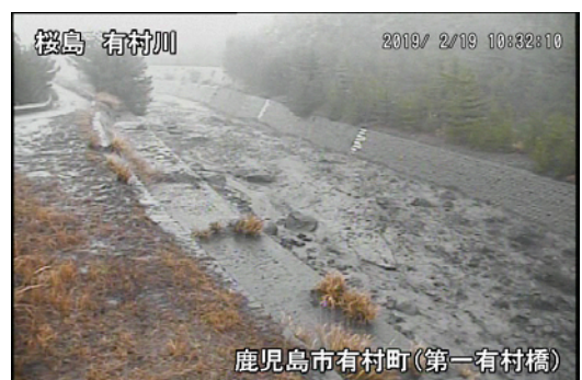
有村川1号橋上流右岸 10:32 頃
