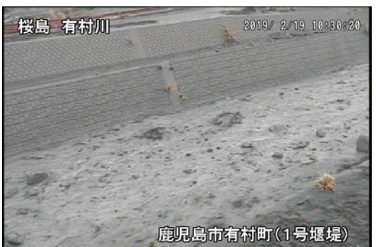
有村川1号堰堤 10:30 頃
