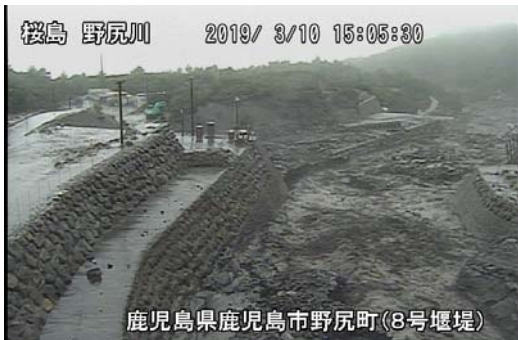
野尻川8号堰堤 15:05 頃
