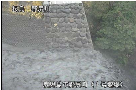
野尻川1号堰堤右岸 16:53 頃
