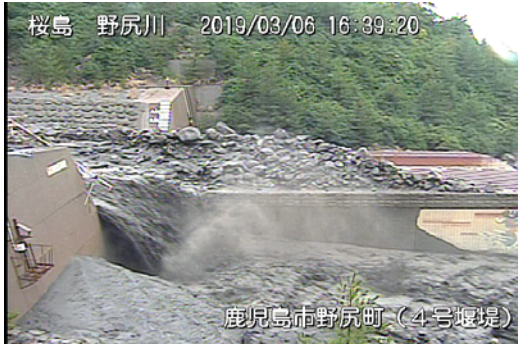
野尻川4号堰堤右岸 16:39 頃
