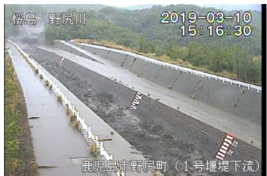
野尻川1号堰堤下流 15:16 頃
