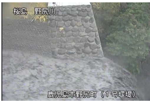
野尻川1号堰堤右岸 15:15 頃
