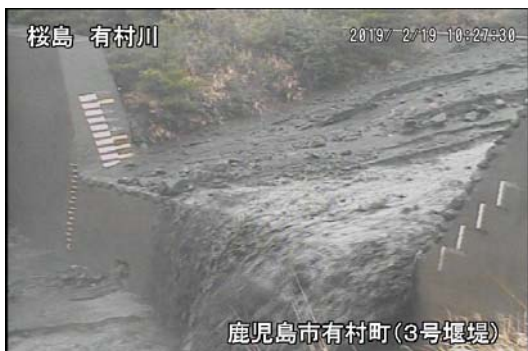
有村川3号堰堤 10:27 頃
