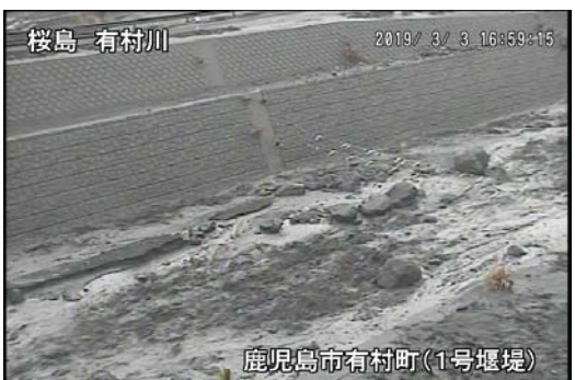
有村川1号堰堤 16:59 頃
