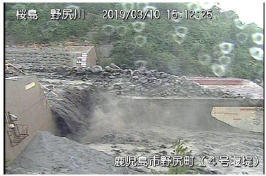
野尻川4号堰堤右岸 15:12 頃
