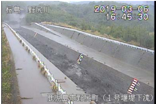
野尻川1号堰堤下流 16:45 頃
