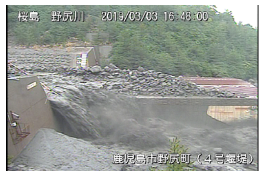
野尻川4号堰堤右岸 16:48 頃
