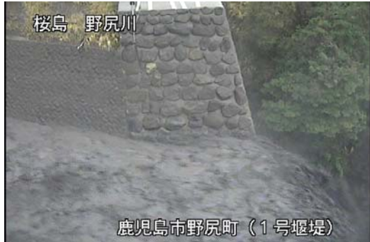
野尻川1号堰堤右岸 16:44 頃
