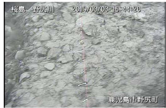
野尻川7号堰堤 16:44 頃
