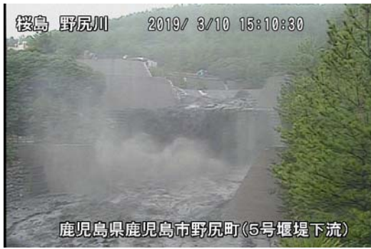
野尻川5号堰堤下流 15:10 頃
