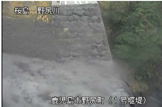
野尻川1号堰堤右岸 10:00 頃
