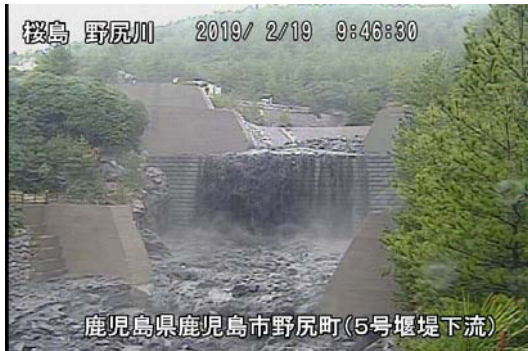
野尻川5号堰堤下流 9:46 頃
