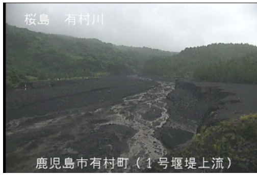
有村川土石流の様子(6月28日)
