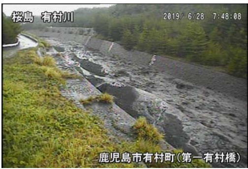
有村川土石流の様子(6月28日)
