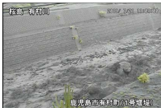
有村川 1 号堰堤
