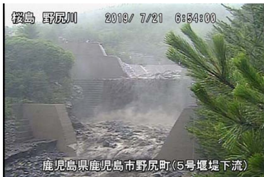
野尻川 5 号堰堤下流
