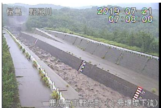
野尻川 1 号堰堤下流
