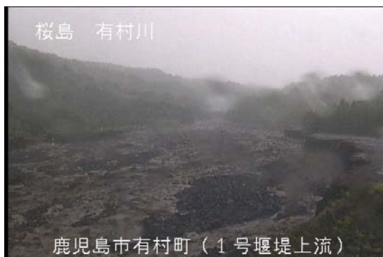
有村川 1 号堰堤上流
