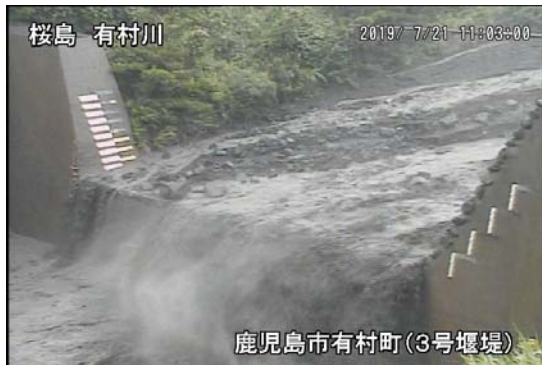
有村川 3 号堰堤
