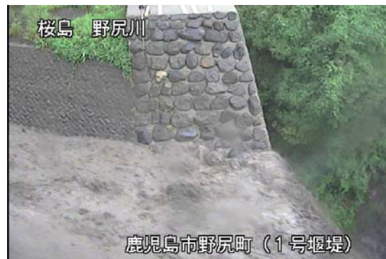
野尻川 1 号堰堤右岸
