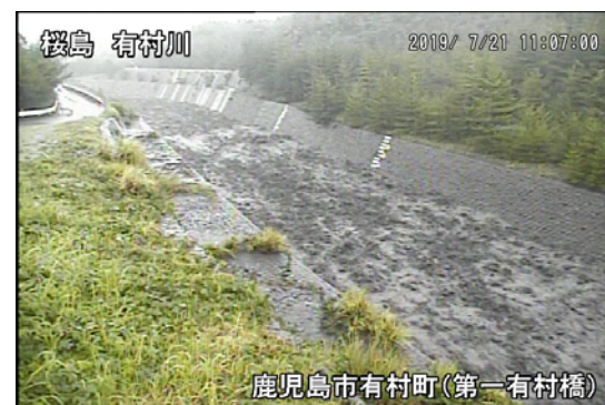
有村川 1 号橋上流右岸
