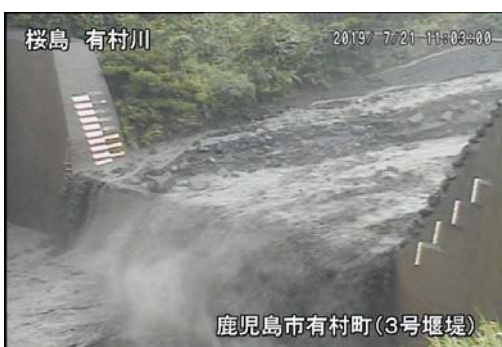
有村川土石流の様子(7月21日)
