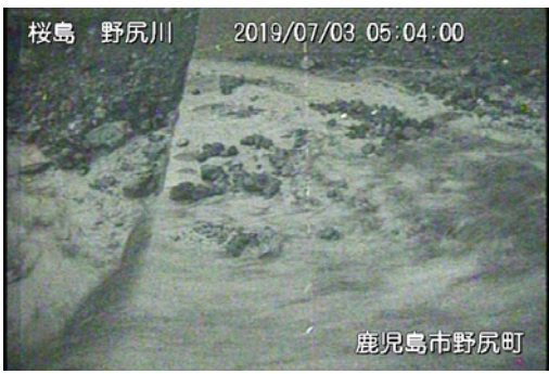
野尻川土石流の様子(7月3日)
