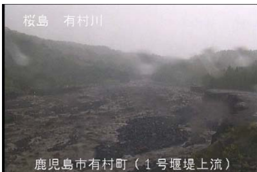
有村川土石流の様子(7月21日)
