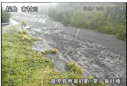
有村川土石流の様子(7月21日)
