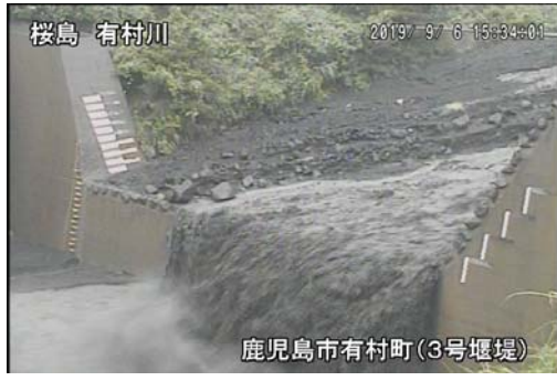
有村川土石流の様子(9月6日)
