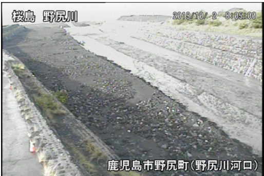
野尻川土石流の様子(10月2日)
