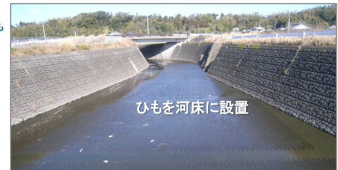
簡易な水質浄化施設(5号排水路)
