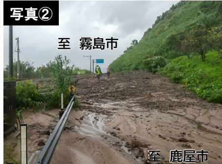
▲崩土のあった国道220号 (垂水市牛根境・R4.9台風)
