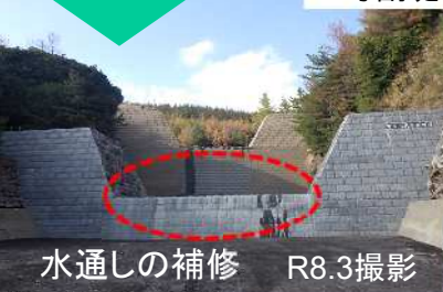
野尻川 5号副堤
