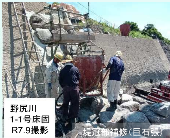
補修(摩耗対策)
