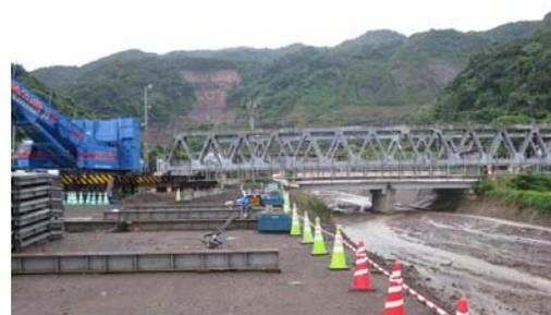
◆大型クレーンによる仮橋架設状況
