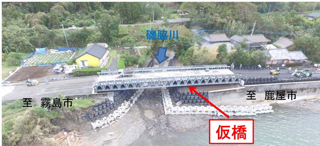
◆流失した磯脇橋の仮橋供用(H28.9.27)
