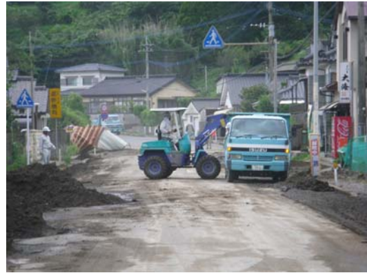
◆国道220号の土砂撤去状況
