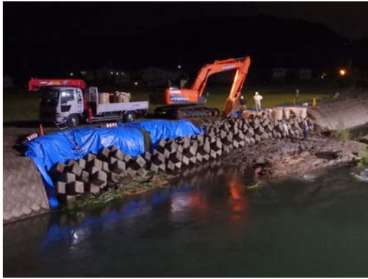
◆肝属川(鹿屋市祓川地区)河岸洗掘箇所 の応急復旧工事施行状況
