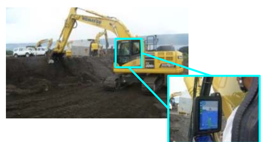
▲3次元データによりICT建設機械 を自動制御し切土等の施工実施
