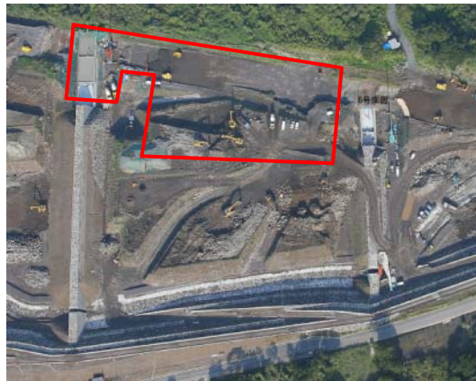
▲長谷川5号床固工・右岸導流堤工事の説明
